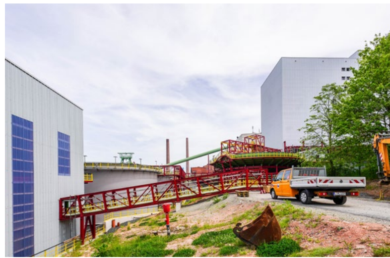
^ Rohrbrücke mit GFK-Ableitungen im K+S Werk Werra, Hattorf
