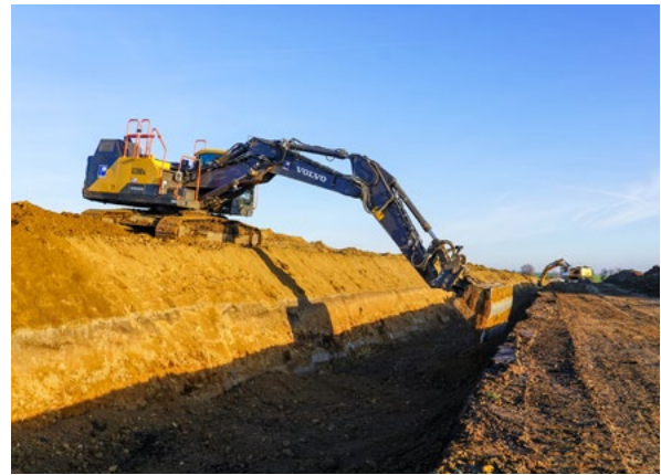
^ Tiefbaumaßnahmen Ohrafernleitung bei Tröchtelborn
